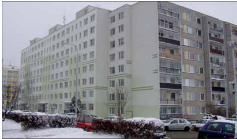
Testování patních měřidel teplé vody v reálných podmínkách bytových domů odhaluje spoustu problémů technického i právního charakteru.
